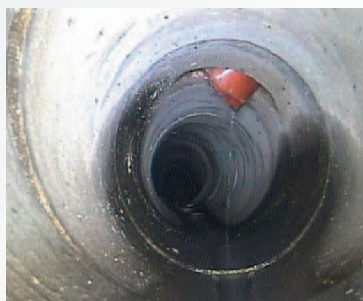
Bild oben: Private Hausanschlüsse sollten fachkundig verlegt werden. Bild unten: Ein ungesicherter Hausanschluss ragt in eine Hauptleitung.
